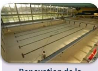
Renovation de la piscine 204 000 Euros
