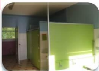
École Meliès , mise en conformité PMR 13 596 €
