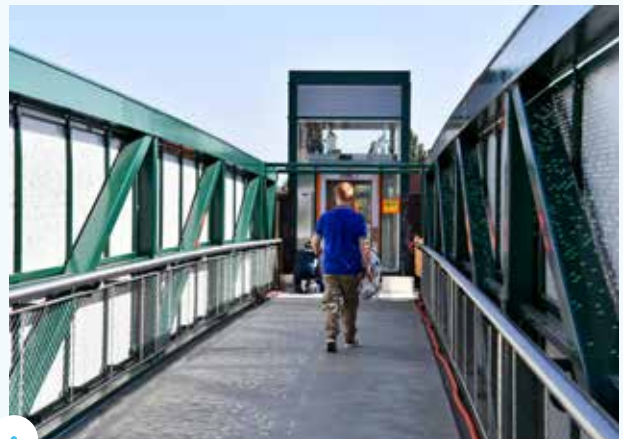
La nouvelle passerelle de Rouges Barres avec ascenseurs.
