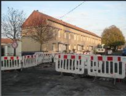
ENFOUISSEMENTS ST SAENS-DUNANT-MASSENET : 870 000 €
